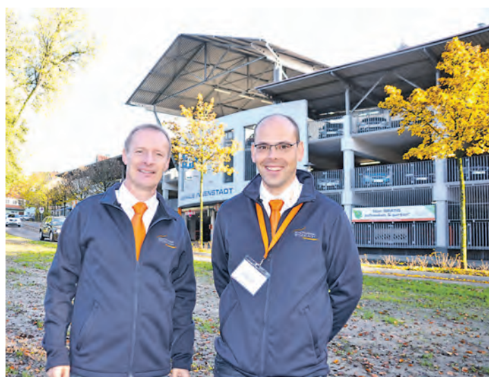
Das Stockacher Parkhaus am Hägerweg wurde modernisiert, renoviert und saniert - sehr zur Freude von Geschäftsführer Jürgen Fürst (links) und Projektleiter Tobias Graf. swb-Bild: sw
