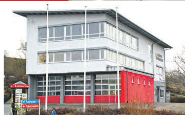
Das neue Bauhofgebäude in Mühlingen besticht auch durch seine zentrale Lage in unmittelbarer Nähe von Rathaus (unser Foto) und Feuerwehr. Im Frühjahr 2014 war mit den Bauarbeiten begonnen worden.
