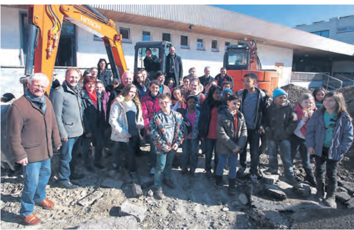
Großer Andrang herrschte beim Spatenstich zum Anbau der Mensa an der Beethovenschule. Im Bagger Schulleiter Oliver Schmohl und OB Bernd Häusler.
