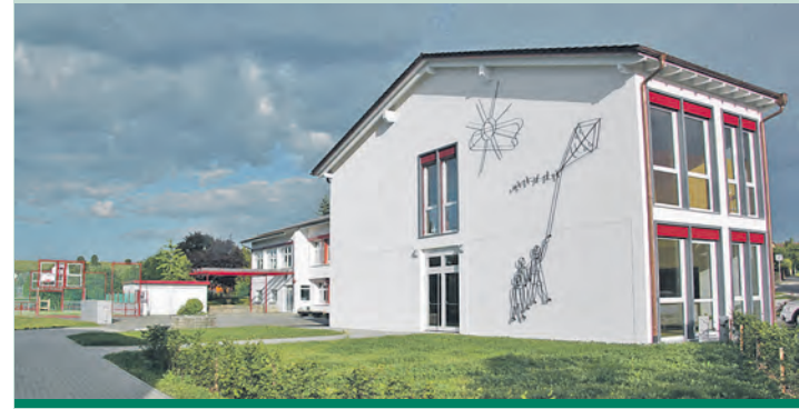
Die Grundschule in Nenzingen hat einen neuen Anbau hin zur Bahnhofstraße für die Ganztagesbetreuung erhalten.
