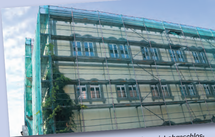
Die Putz und Sandsteinsanierung am Rathaus ist abgeschlossen.
