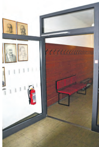
Sicherheit wird im Rathaus großgeschrieben: In jeder Etage wurden Brandschutztüren eingebaut.
