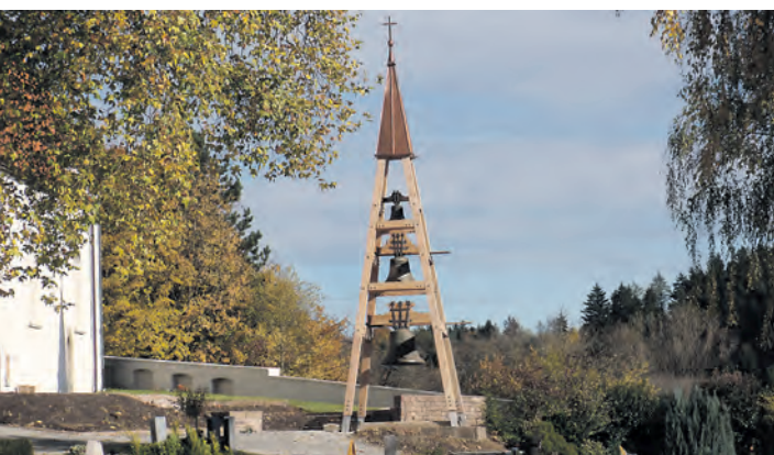
Besonders die Restaurierung und Sanierung von denkmalgeschützten Gebäuden wird bei »Holzbau Massler« großgeschrieben. Derzeit wird unter anderem an der Sanierung des ehemaligen Chorherrenstiftes in Öhningen mitgewirkt.
