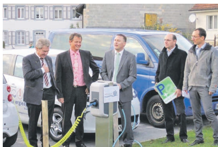
Im Beisein von Landrat Frank Hämmerle (links) wurde die neue Stromtankstelle für Elektromobilität auf dem Rathausvorplatz in Eigeltingen eingeweiht. swb-Bild: Gemeinde Eigeltingen
