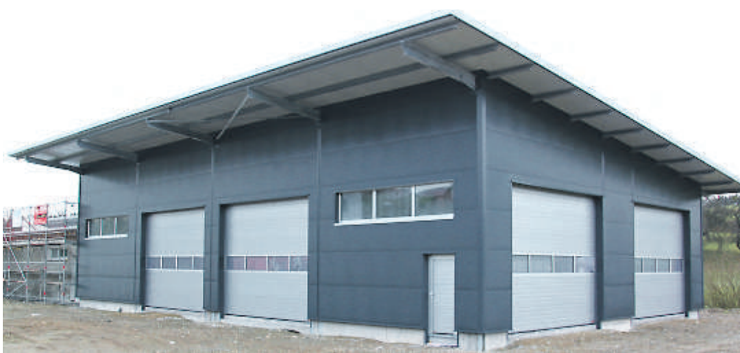
In dem Neubau an der Hauptstraße 1 in Mühligen werden der örtliche Bauhof mit seinen großen Fahrzeugen, der Musikverein Mühligen sowie die Musikschule Mühligen-Zoznegg untergebracht.
