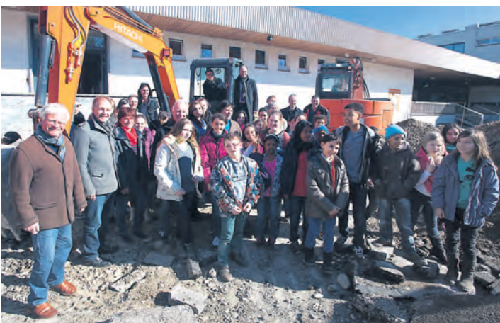
Großer Andrang herrschte beim Spatenstich zum Anbau der Mensa an der Beethovenschule. Im Bagger Schulleiter Oliver Schmohl und OB Bernd Häusler.
