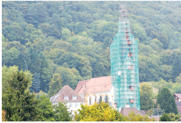
Wahrzeichen mit Gerüst: Im Moment wird der Turm der Pfarrkirche St. Dionysius in Gailingen saniert.
