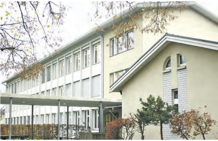
Die Schulgemeinde Region Diessenhofen will in einigen Jahren das Oberstufengebäude abreißen. Dem stellen die Behörden den Denkmalschutz entgegen.
