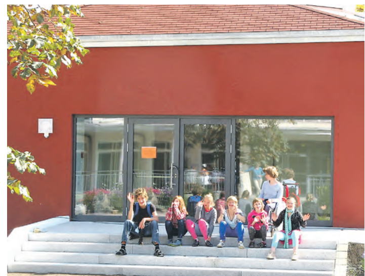
Mit dem Neubau der Lehrwerkstätten hat das Haus am Mühlebach in diesem Jahr eine große Last geschultert. Mitarbeiter und Bewohner freuen sich über den zusätzlichen Platz für eine noch bessere Ausbildung.
