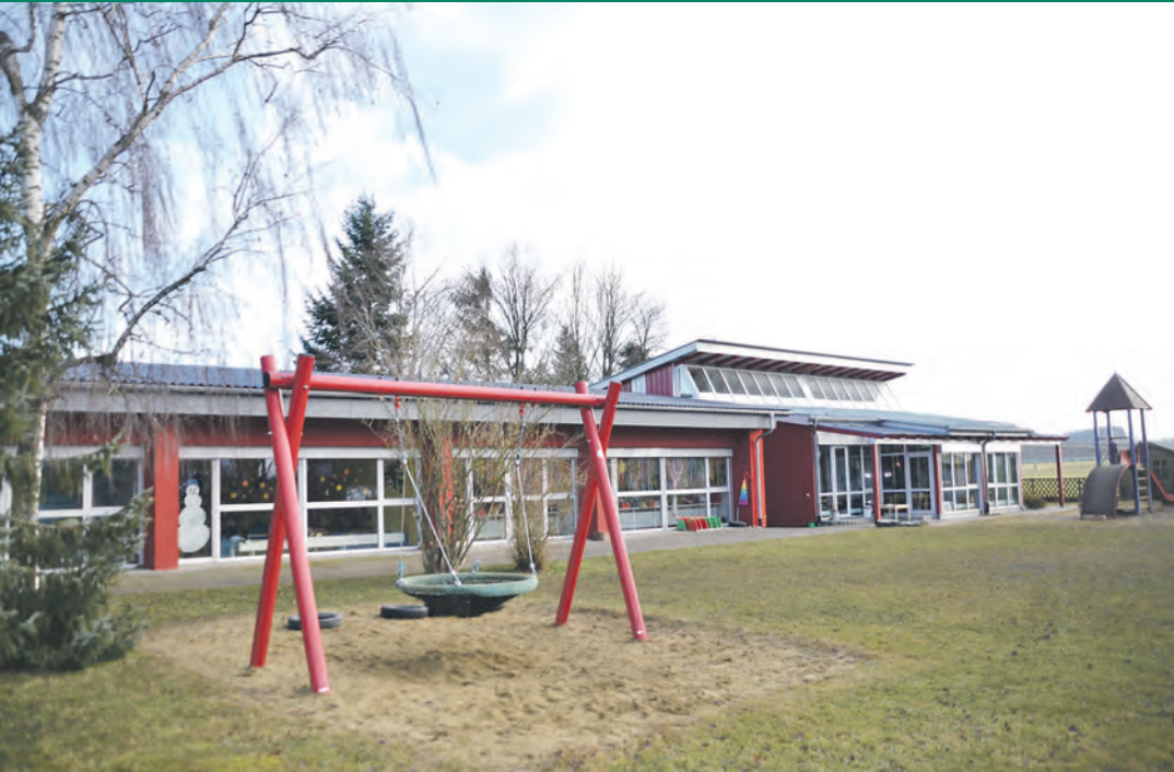
Der Kindergarten bei der Hohenfelshalle in Liggersdorf wurde saniert und hat einen Anbau erhalten.
