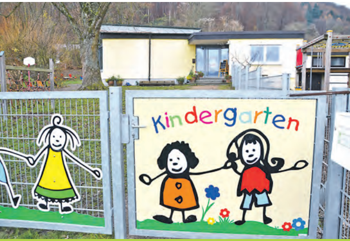
Der Kindergarten »Casa dei Bambini« in Bodman hat einen Anbau erhalten und wurde im Altbestand saniert. swb-Bild: of
