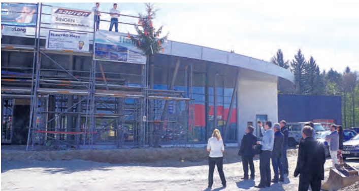
Mit einer illustren Gästeschar und seiner Familie konnte am Freitag Klaus Bach Richtfest für das neue Toyota-Autohaus in Singens Süden feiern. Es wird durch ein ellipsenförmiges Dach Aushängeschild für die Automeile in Singen.
