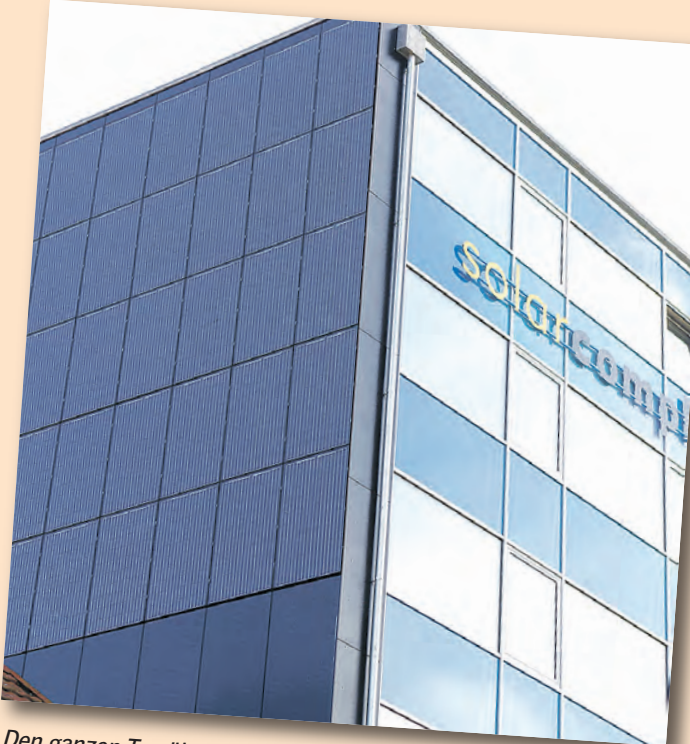
Den ganzen Tag über wird die Sonne beim Solarcomplex-Haus eingefangen um Strom zu produzieren. Zusätzlich sind rund 30 Quadratmeter für thermische Solarnutzung vorgesehen.
