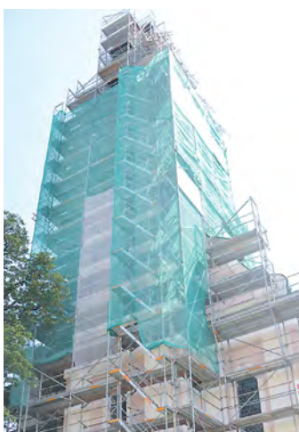
Eingerüstet und verpackt: Die St.-Peter-und-Paul-Kirche wird derzeit aufwändig renoviert.
