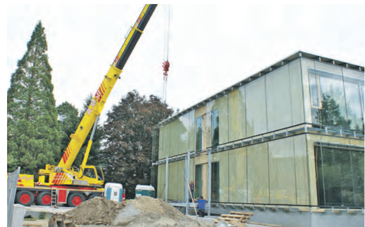
Mit Hochdruck wird derzeit an der Fertigstellung des Schulhausneubaus in Steißlingen gearbeitet.
