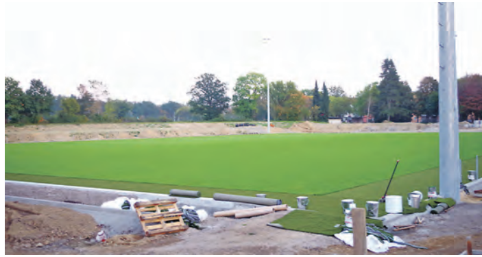
Der Rollrasen im Hohentwielstadion ist ausgebracht. In den nächsten Tagen sollen die Leuchten an den Flutlichtmasten montiert werden.
