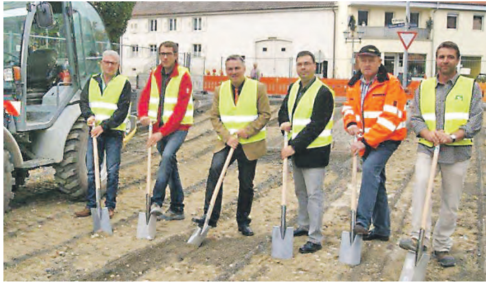
Spatenstich für die Umbaumaßnahmen in der Albert-ten-Brink-Straße: Im Bild (v. L.) Burkhard Raff, Daniel Schrodin, RP Neubaulaufleitung Singen, Bürgermeister Ralf Baumert, Burkhard Schmallenbach, Ortsbauamt, Rolf Mahlbacher, Tiefbauamt, und Alexander Müller, Bauleiter Firma Schleith.
