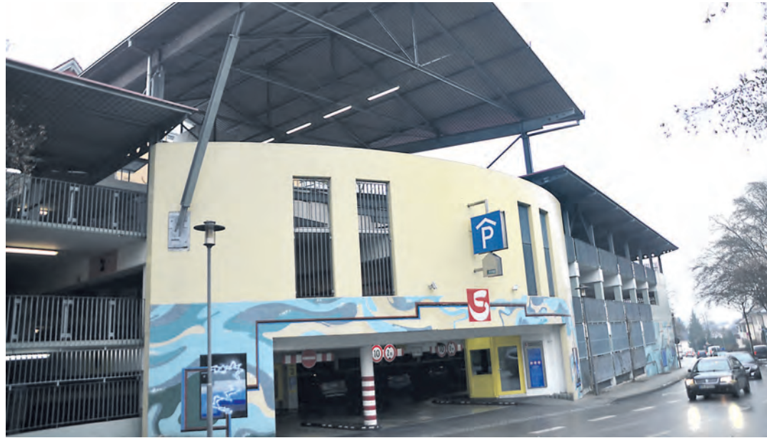
Das Parkhaus am Hägerweg soll ab Frühjahr 2014 eine Schrankenanlage erhalten. swb-Bild: sw
