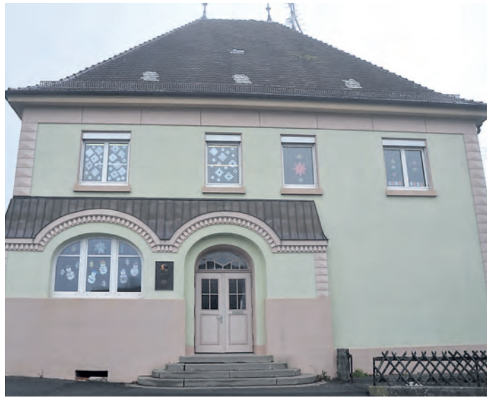
In Hohenfels wird ein neues Schulhaus gebaut, doch über die Zukunft der bisherigen Korbinian-Brodmann-Schule (unser Foto) wurde noch nicht entschieden.
