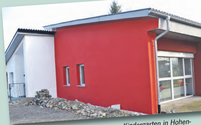
2011 wurde mit den Bauarbeiten am Kindergarten in Hohenfels begonnen, in diesem Jahr werden alle Maßnahmen abgeschlossen sein.
