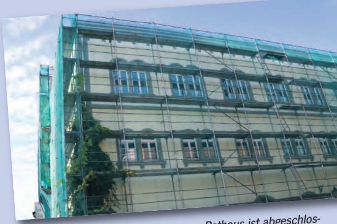
Die Putz- und Sandsteinsanierung am Rathaus ist abgeschlossen.
