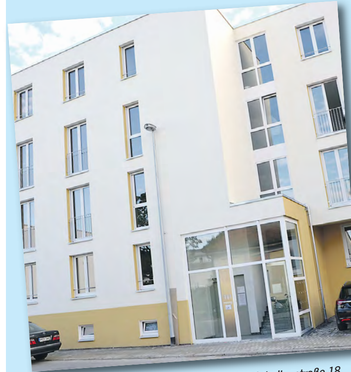
Die 18 Wohneinheiten in der Radolfzeller Markthallenstraße 18 stehen kurz vor dem Abschluss.
