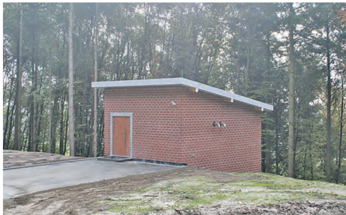
Der neue Hochbehälter bei Raithaslach versorgt etwa 2.700 Einwohner Stockachs mit Wasser. swb-Bilder: Stadtwerke
