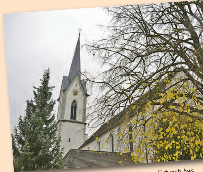
Das neu gestaltete katholische Gemeindezentrum fügt sich harmonisch in die Umgebung auch mit der Kirche ein.
