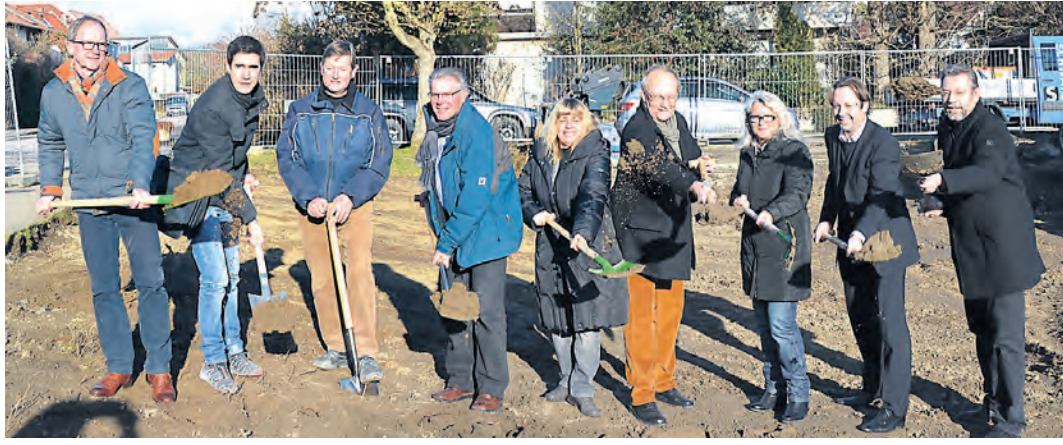
Mit dem Spatenstich gaben sie gemeinsam den Startschuss für den Neubau der Sozialstation Hegau West e.V. St. Martin, die bis nächstes Frühjahr fertig sein soll. Im Bild von links: Die Architekten Wolfgang Riede und Lukas Hahn, Hubert Keppler vom Radolfzeller Bauunternehmen Böhler und Brutscher, Roland Maus, 2. Vorsitzender aus Gottmadingen, Martina Barner, 2. Vorsitzende aus Büsingen, Projektleiter Wolf-Rüdiger Weber, Leiterin Elisabeth Waibel, Gottmadingens Bürgermeister Dr. Michael Klinger und Markus Möll, Bürgermeister aus Büsingen. swb-Bild: mu
