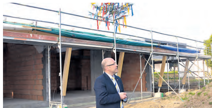
In Riedheim entstehen Krippenplätze für 20 Kinder im Alter von ein bis drei Jahren. Im Bild Bürgermeister Rupert Metzler.
