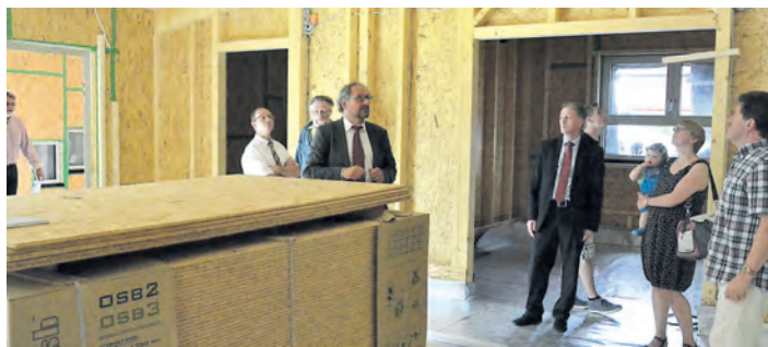
Neugierige Blicke beispielsweise von Bürgermeister Moser beim Richtfest der Kinderkrippe »Im Baumgarten«. swb-Bild: sam
