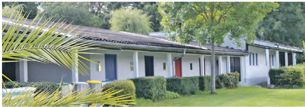
Die Sanitärgebäude mit Umkleide, Kasse und Kiosk im Engener Erlebnisbad sind in die Jahre gekommen und sollen nun saniert werden.
