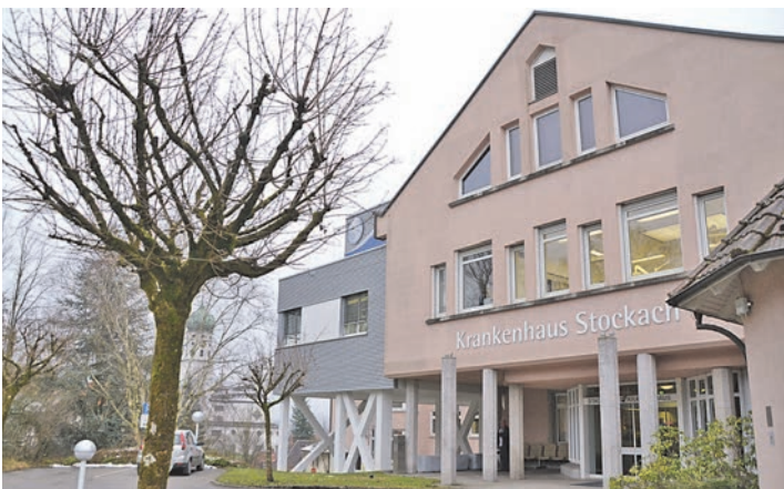
Das Stockacher Krankenhaus soll in Richtung Nordosten einen neuen Anbau erhalten und im Bestand saniert werden. swb-Bild: sw
