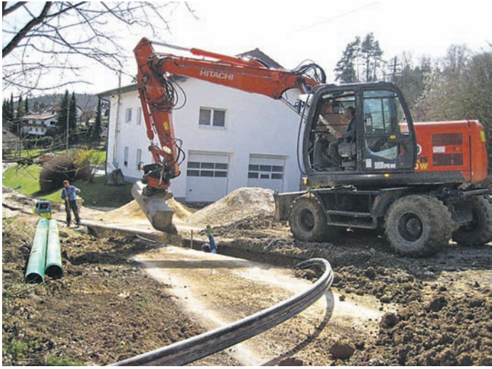
Die Bauarbeiten im Eigeltinger Ortsteil Eckartsbrunn liegen voll im Zeitplan.
