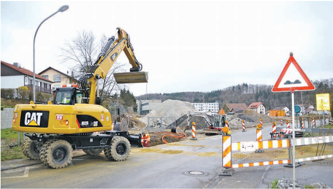
In Stockach wird gebaut. Verschiedene Maßnahmen stehen in den nächsten Jahren an, gab Bürgermeister Rainer Stolz im Rahmen der Bürgerversammlung in der »Adler Post« bekannt.
