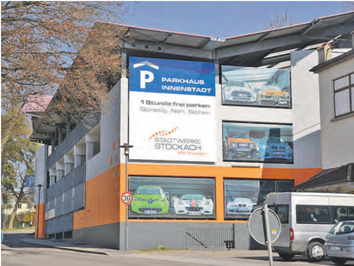
Mit 123.000 roten Euro belastete das Parkhaus im Hägerweg die Bilanz der Stadtwerke Stockach. swb-Bild: Stadtwerke
