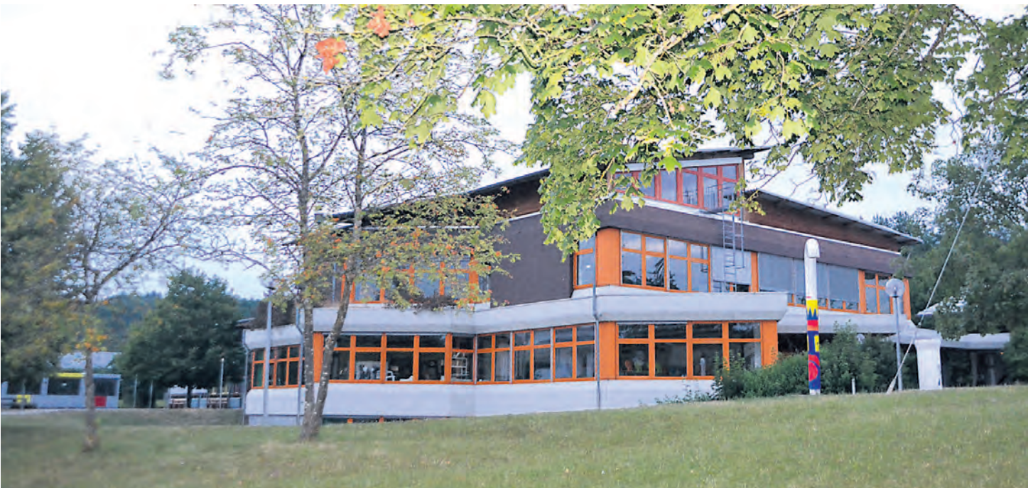
Die Heizungs- und Lüftungsanlagen der Gemeinschaftsschule Eigeltingen werden instand gesetzt.
