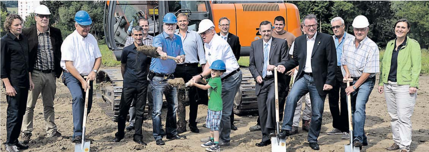
Stockacher Prominenz aus Politik, Gesellschaft und Wirtschaft traf sich zum symbolischen ersten Spatenstich im Gewann »Galgenäcker« in Hindelwangen. Die Baugenossenschaft Stockach lässt hier ein Mietwohnungshaus mit 14 Wohnungen entstehen. swb-Bild: sw
