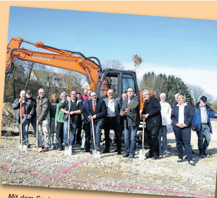
Mit dem Spatenstich für den Netto Marken Discount auf dem ehemaligen EMA-Areal in Aach nahm eine lange Geschichte ein glückliches Ende. swb-Bild: Archiv/mu
