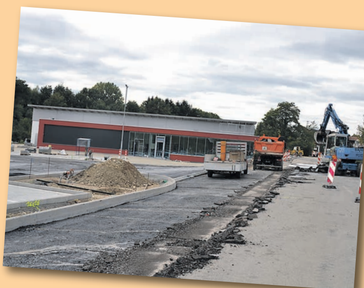
Als dieses Foto entstand, wurde noch fleißig gebaut - mittlerweile ist der Netto-Markt in Aach fertig und strahlt in den typischen rot-gelben Farben. swb-Bild: rab
