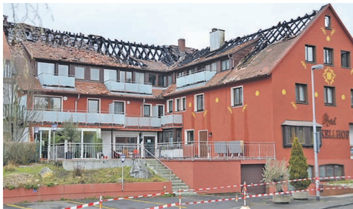
Nach dem Brand »Kellhof« zu Beginn 2015 verabschiedete der Markelfinger Ortschaftsrat einstimmig den Baubeschluss für den Wiederaufbau des Hotels.
