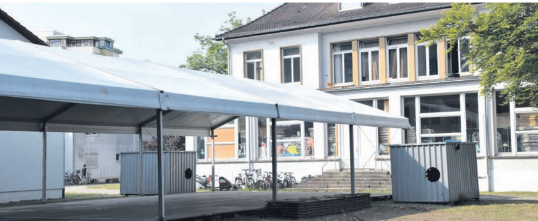
Die neue Leichtbauhalle bei der Gemeinschaftsunterkunft in der Kasernenstraße soll Platz für rund 100 Flüchtlinge bieten. Bis September ist mit einem Einzug zu rechnen. swb-Bild: gü
