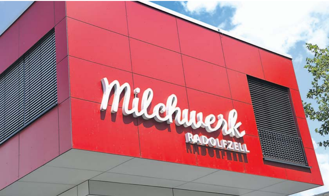
Das Milchwerk wird im Zuge von Sanierungsarbeiten im Sommer 2016 für elf Wochen geschlossen. Insgesamt belaufen sich die Kosten auf 645.000 Euro. swb-Bild: gü
