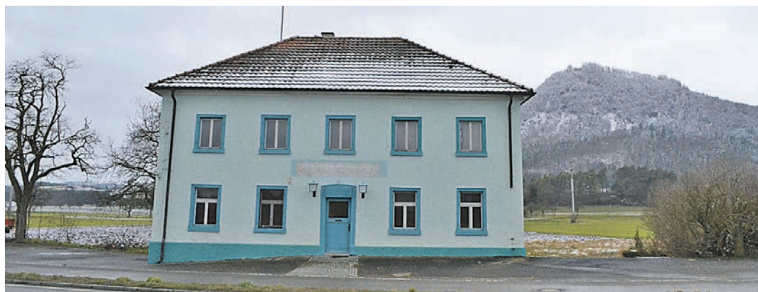
Das »Bahnhöfle« in Neuhausen soll abgerissen und dafür eine modulare Flüchtlingsunterkunft erstellt werden. swb-Bild: sam
