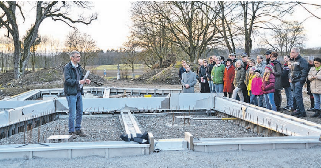
Baustellenbesichtigung im neuen Höhenfreibad: Hier entsteht ein Bade- und Plantschparadies für die ganze Familie.
