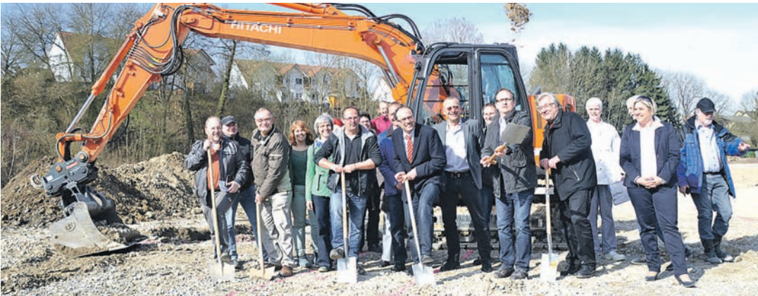
Nach langen Verhandlungen wurde mit dem Spatenstich für den neuen Lebensmitteldiscounter auf dem ehemaligen EMA-Areal in Aach der offizielle Baubeginn gestartet. swb-Bild: mu
