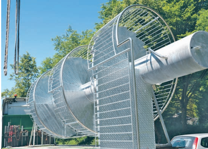
Acht Meter hoch ist der Treppenturm für die Speedrutsche, der am Montag mit einem 200 Tonnen-Kran auf seinen Platz gehievt wurde. swb-Bild: mu
