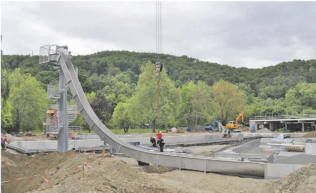
Geschafft: Die rasante Speedrutsche mit dem Treppenturm steht im neuen Höhenfreibad.
