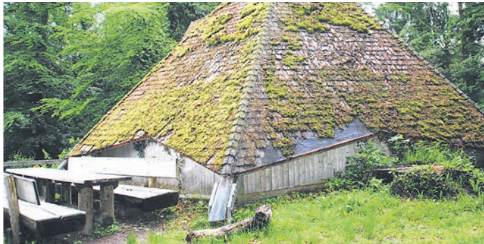
Die Wetterschutzhütte »Ramsener Blick« ist in die Jahre gekommen und wird saniert. An den Renovierungsarbeiten beteiligen sich Fachleute, der Bauhof und freiwillige Helfer.
