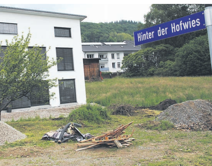
In Kürze wird mit den Bauarbeiten für den im Bebauungsplan vorgesehenen neuen Kinderspielplatz begonnen. swb-Bild: hz
