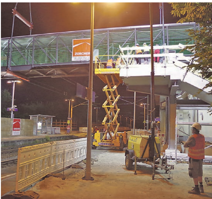
Erst im zweiten Anlauf konnte die Brücke über den Gottmadinger Bahnhof an der richtigen Stelle platziert werden. Dadurch gingen die Arbeiten über zwei Stunden länger als geplant in der Nacht auf Samstag. of swb-Bild: of
