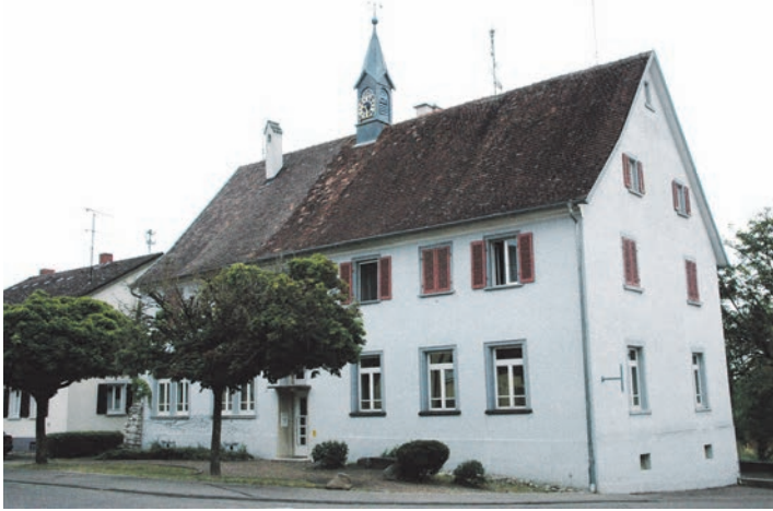
Im alten Schulhaus von Ehingen finden demnächst sieben bis acht Menschen ein neues Zuhause. swb-Bild: rab
