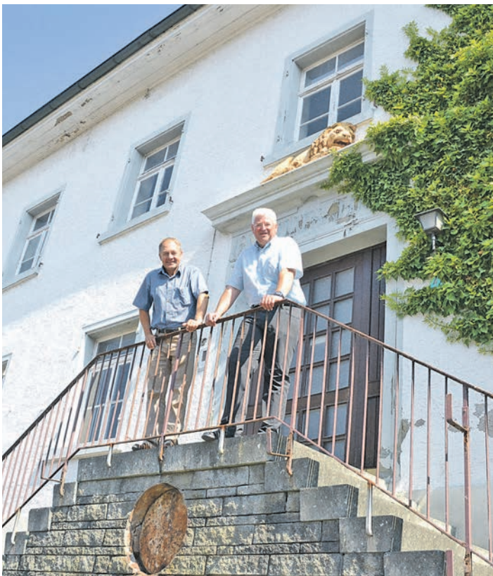
Der »Löwen« in Gailingen ist Dreh- und Angelpunkt des nächsten großen Sanierungsprojektes der Gemeinde. Dort sollen seniorengerechte Wohnkomplexe entstehen. Die ortsbildprägende Fassade des Gebäudes möchte man erhalten. MdL Hans-Peter Storz (li) und Bürgermeister Heinz Brennenstuhl machen sich ein Bild von den Sanierungsergebnissen im Ort.
