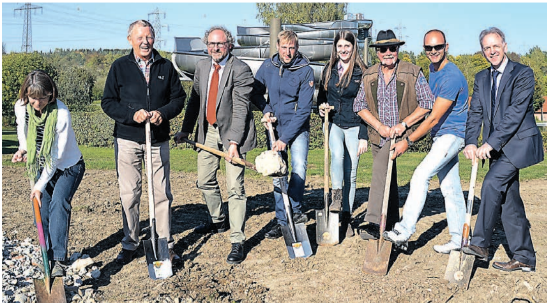
Den symbolischen Spatenstich führten durch (v. l.): Bauleiterin Ingrid Bantel, Moritz Kamenzin, Gründungsmitglied des Erlebnisbades, Stadtbaumeister Matthias Distler, Thomas Eschbach (Baufirma in Mühlhausen-Ehingen), Karen Bieler, Vorsitzende des Jugendgemeinderates, die beiden Schwimmmeister Roland Kapitel und Thomas Abendroth sowie Bürgermeister Johannes Moser. swb-Bild: mu
