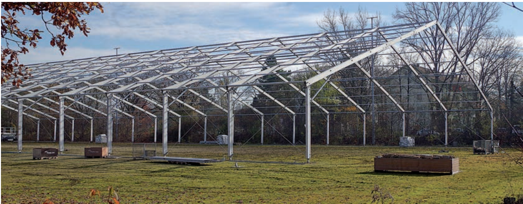
Schon weit fortgeschritten sind die Aufbauarbeiten für eine Leichtbauhalle aus dem ehemaligen Kunst-rasenplatz beim Hohentwielstadion in Singen. swb-Bild: of
