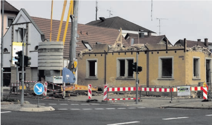
Nach Abriss des »Gerichtsvollzieherhäusles« an der Ecke Ringstraße/Ekkehardstraße entsteht dort ein neues Wohn- und Geschäftshaus.
